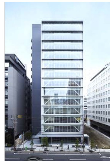
アーバンネット内本町ビル (2011.6竣工) 2012年度グッドデザイン賞
