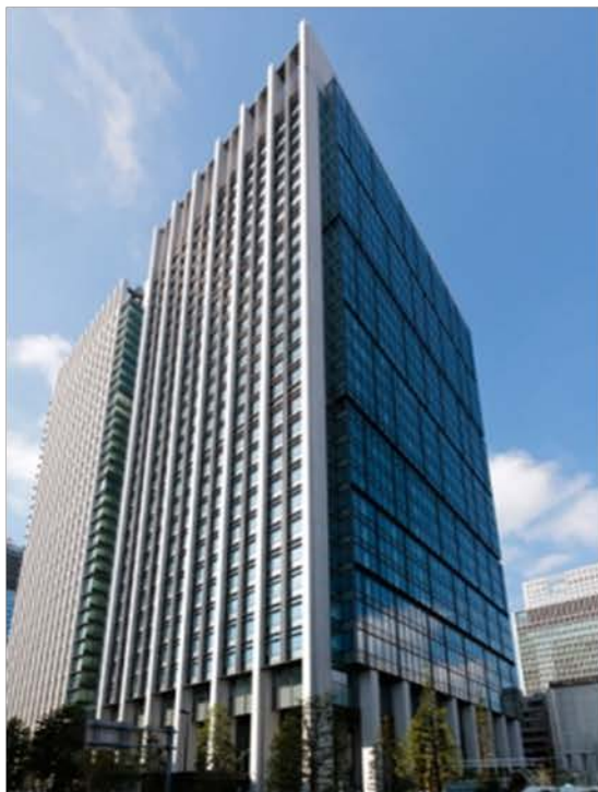
大手町フィナンシャルシティ ノースタワー (2012.10竣工)
