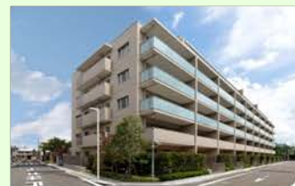
ウェリス桜山(2012.8竣工)
