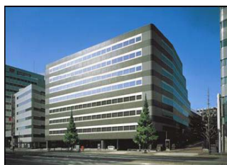
アーバンネット三田ビル
