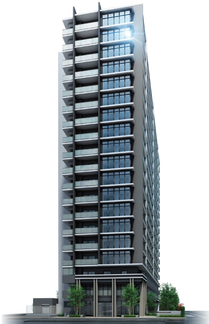
敷地南東側からの外観
