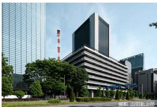
解体前外観：日比谷通りから（2022 年）
