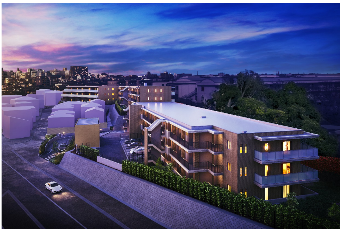
ウエリス湘南台 建物外観
