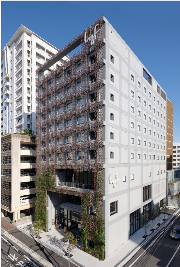
（左）外観 （右上） lyf Tenjin Fukuoka【ホテル】コワーキング/ラウンジ （右下） 灌水システムを備えたキャストアルミファサード photo Kai Nakamura
