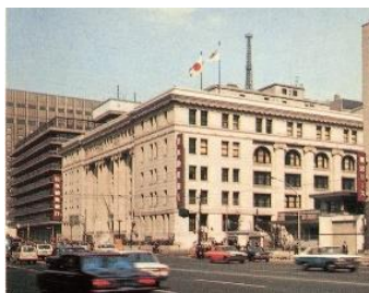
旧 第一勧業銀行本店ビル
