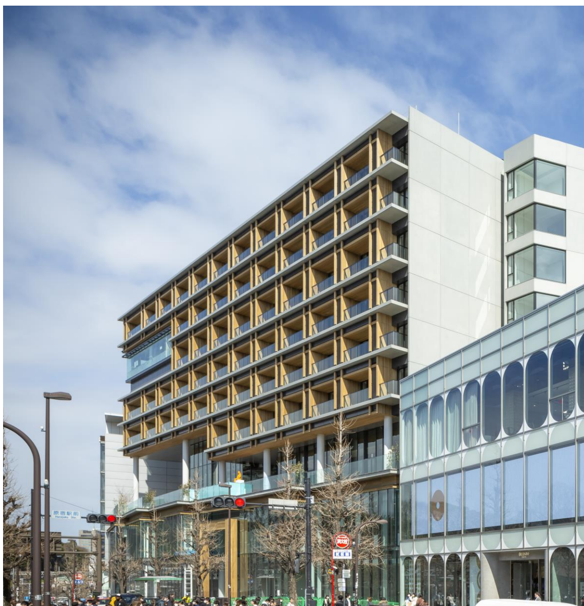
原宿駅側外観（南側） ※
