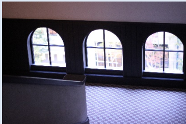
屋上へと続く階段のアーチ窓
