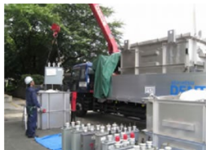
PCB含有機器の無害化処理に向けた搬出作業
