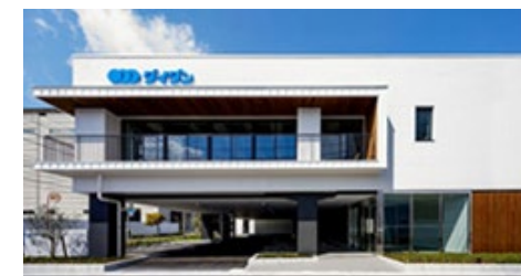
ダイダン四国支店「エネフィス四国」 撮影者：株式会社エスエス大阪支店 秋田 広樹
