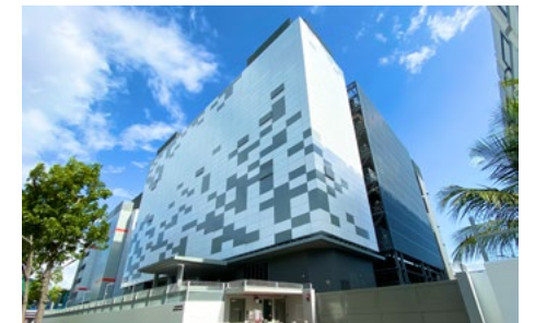
シンガポールでの転換型データセンターの建設例
