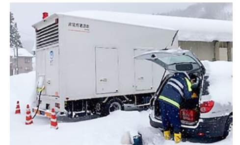
災害復旧の様子
