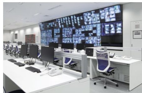
防災センター
