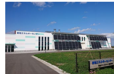
新地エネルギーセンター外観
