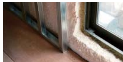
元の断熱材の約2倍の厚みをもたせた発泡ウレタンの断熱材
