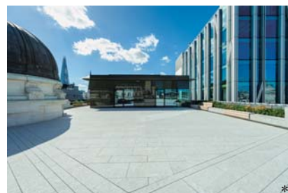
屋上テラス(増床部)
