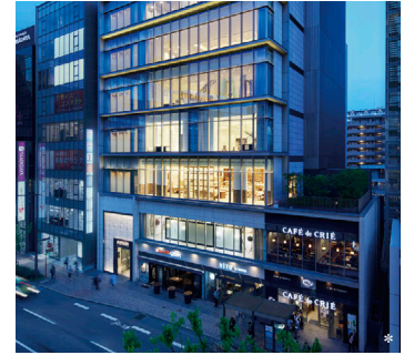
レソラサウステラス
