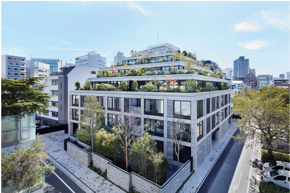
立体的な緑を纏った建物全景
