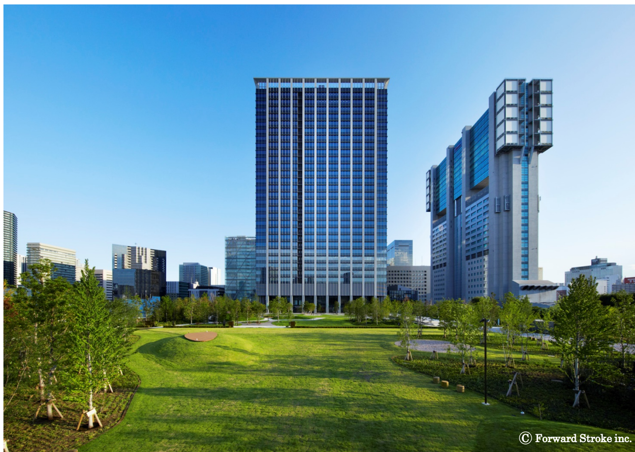
品川シーズンテラス全景
