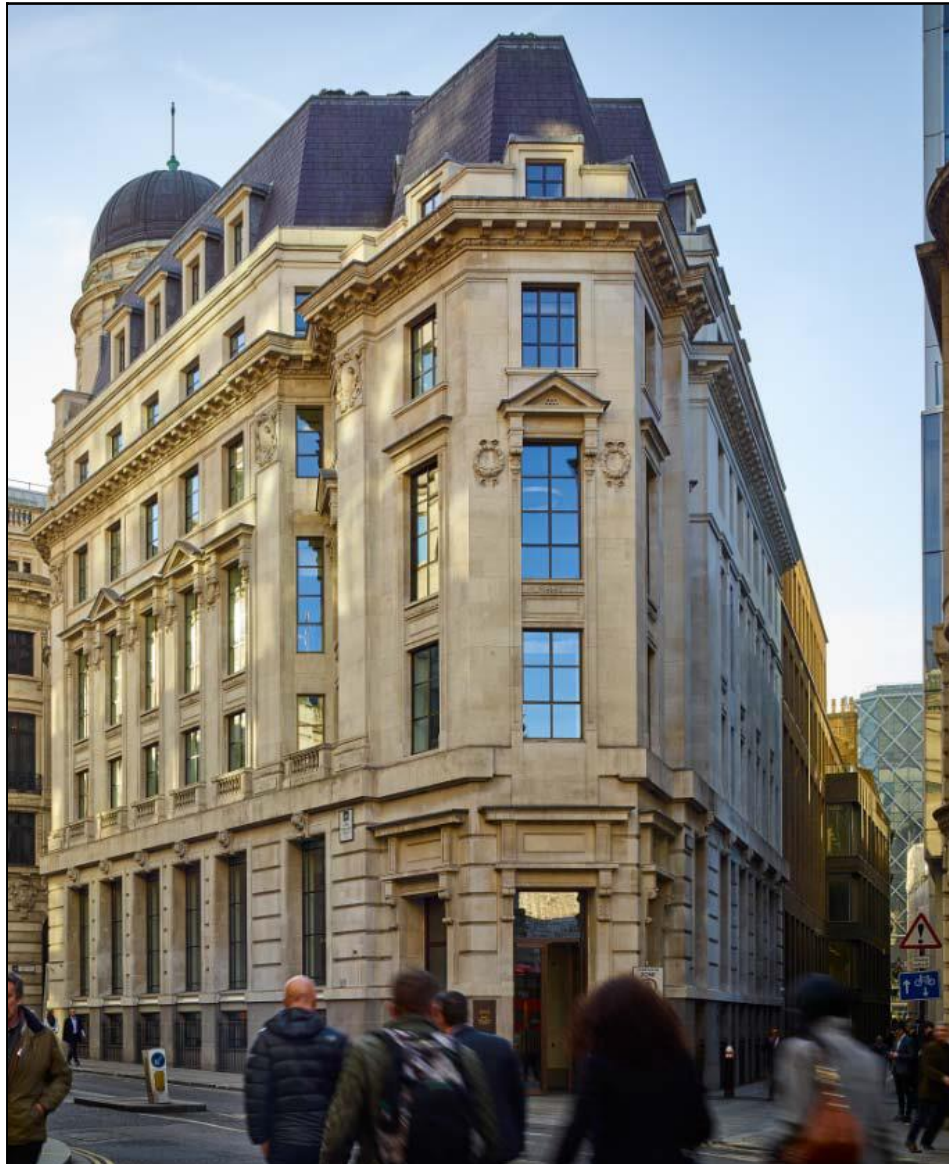
*リニューアル工事実施後
